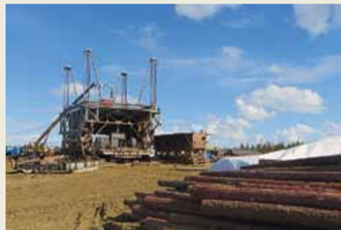
Апрель 2016 г., подготовительные, вышконтражные работы на площадке
