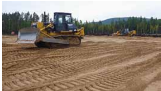
Завершены работы по отсыпке площадки на поисково-оценочной скважине № 6 Имбинского участка
