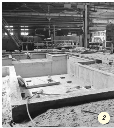
На строительной площадке листоправильного станка
