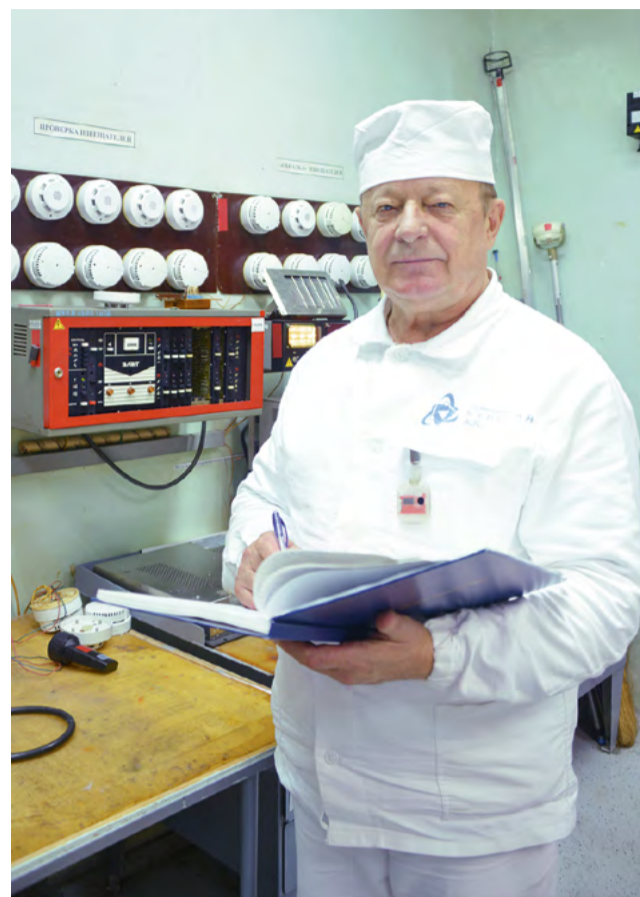
Носитель критических знаний – электромонтер по ремонту аппаратуры РЗА противопожарной автоматики ЭЦ Николай Воробьев. Стаж работы на АЭС 24 года.
