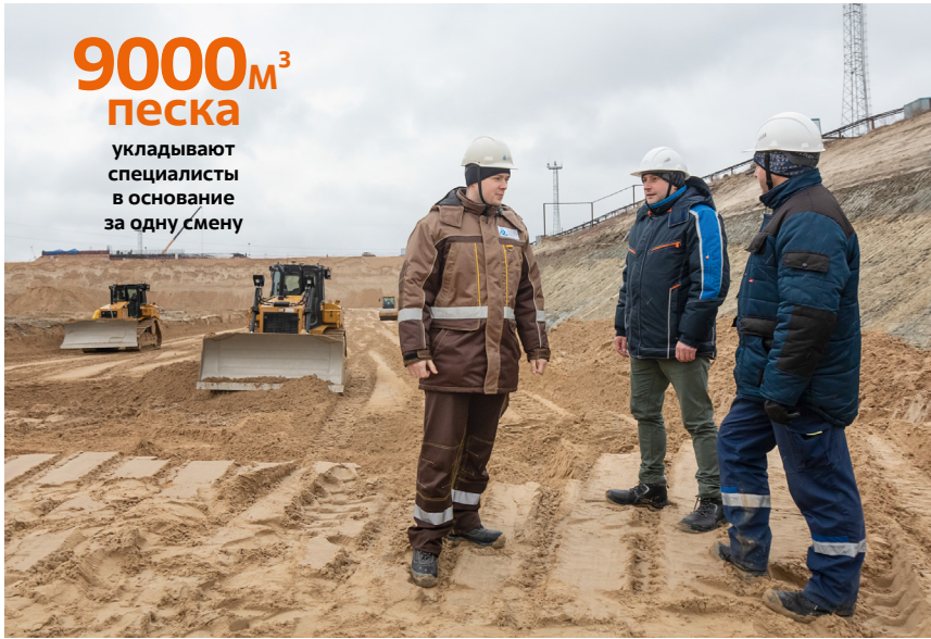
Куратор отдела строительного контроля Евгений Седусов (слева) принимает участок отсыпанного слоя песка у начальника участка Юрия Копцева и мастера строительного-монтажных работ Мариуша Каба
